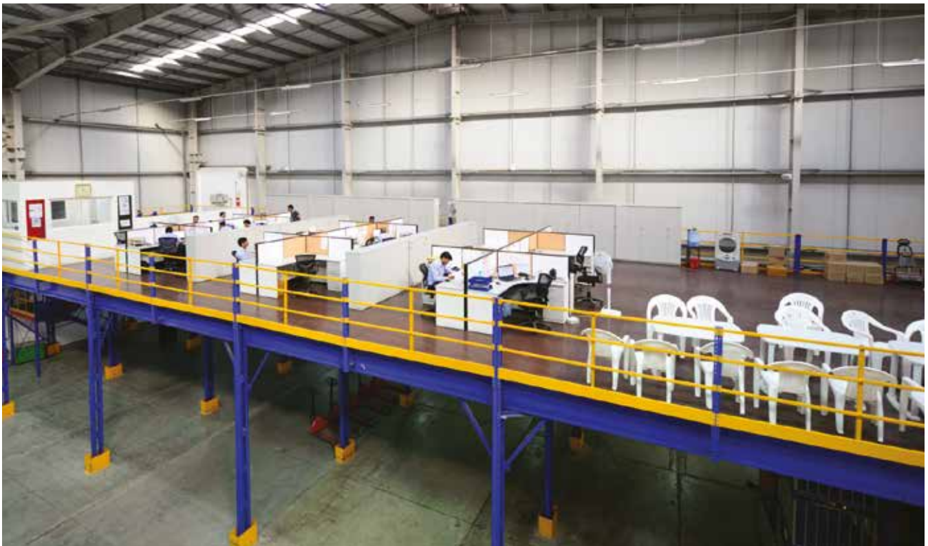
Dự án lắp đặt kệ sàn Mezzanine/ Mezzanine floor projects
